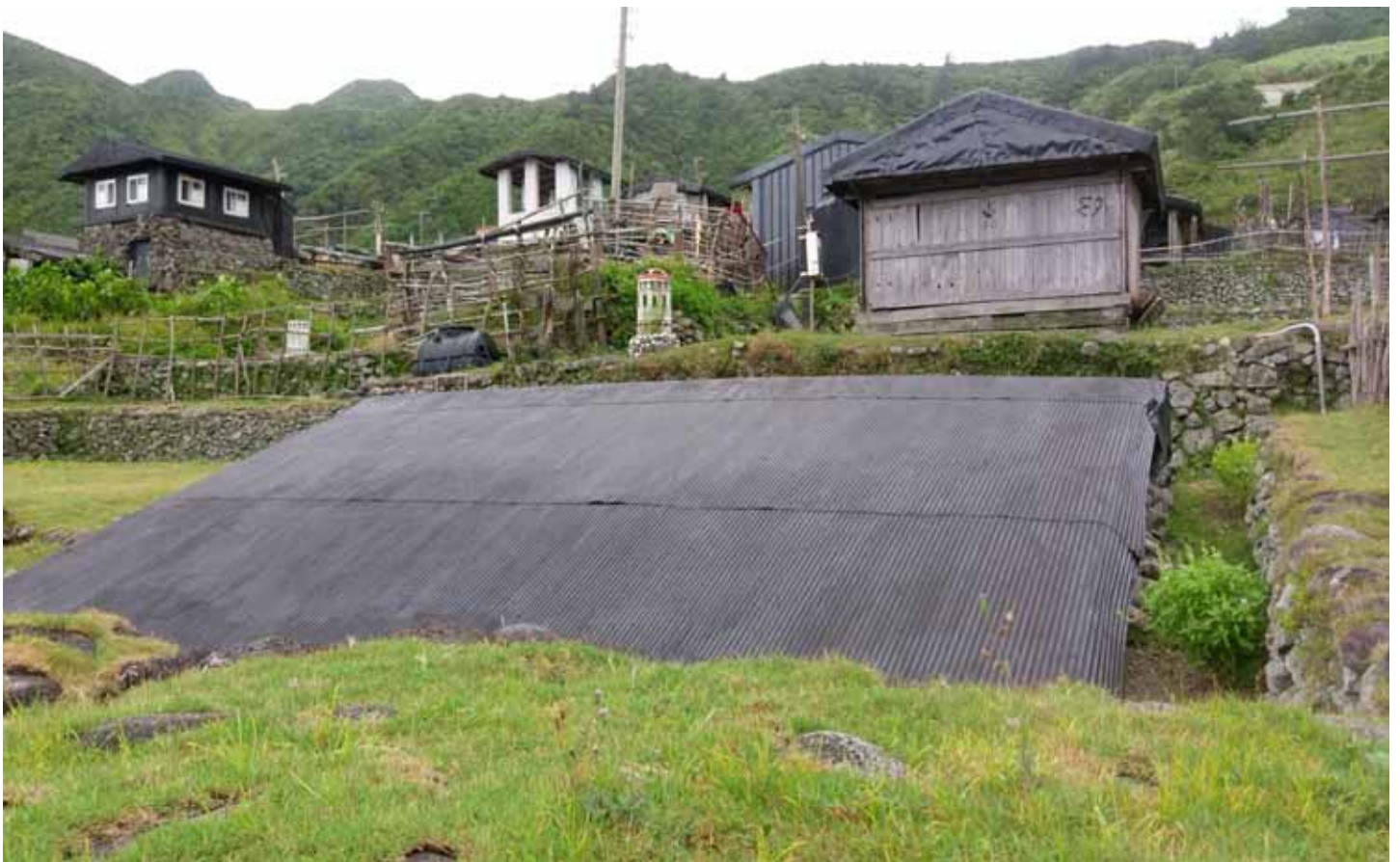
為適應島上特殊氣候(高溫、多雨、多颱風)而發展出獨特半穴型的地下屋
