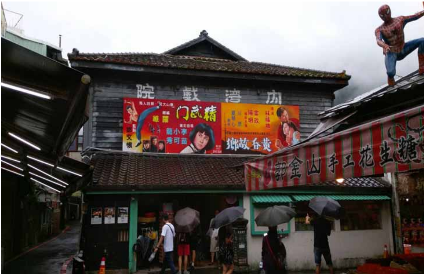
內灣戲院是民國 39 年，林場老闆用上好建材，為提供工人娛樂場所而蓋
